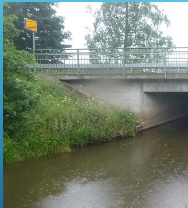
Fehlende Böschungstreppe
