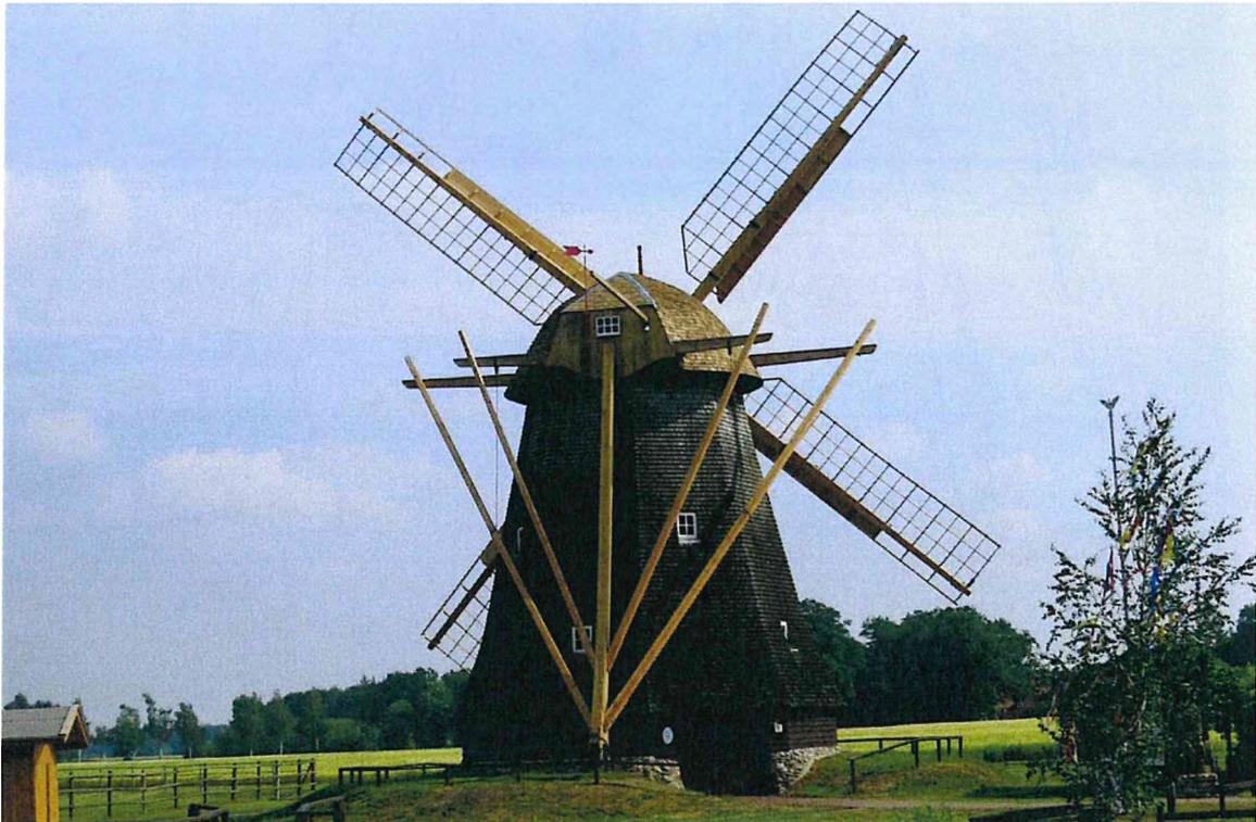
Abb. 14: Bestand im Sommer 2019 nach der Erneuerung der Flügel- und Steertanlage sowie Instandsetzung und Neueindeckung der Kappe.
