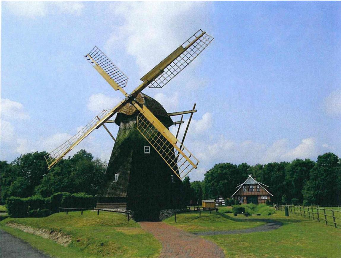
Abb. 13: Bestand im Sommer 2019 nach der Erneuerung der Flügel- und Steertanlage sowie Instandsetzung und Neueindeckung der Kappe.
