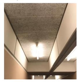
Geschossdecke mit Tektalan zur Schallabsorption
