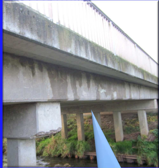
Abdichtungsschäden, Betonabplatzungen
