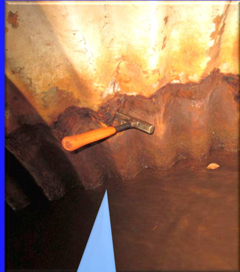
Korrosion
