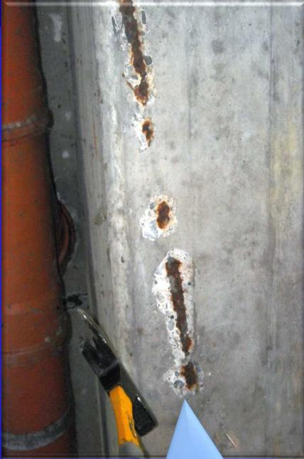
Betonabplatzungen mit freiliegender Bewehrung
